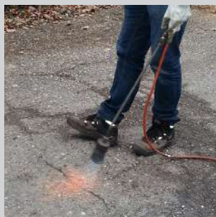
Brossez les saletés et éliminez l'humidité de la fissure à l'aide d'un chalumeau.
