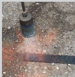
Faites adhérer BandFill à la fissure en chauffant le matériau à l'aide d'un chalumeau.
