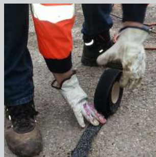
Placez BandFill sur la surface de la fissure.
