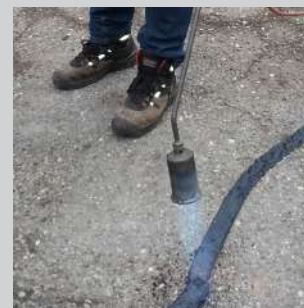
Une chaleur suffisante a été appliquée lorsque le matériau commence à faire des bulles.
